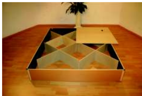
Auflegen der Bodenplatten
