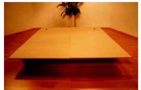
Auflegen der Bodenplatten
